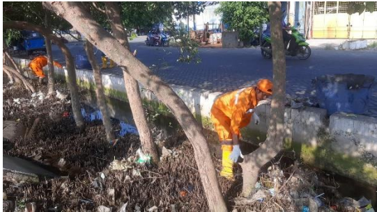
Pembersihan Sampah di Saluran Drainase Jalan Kakap
