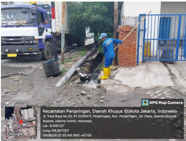
Pembersihan Sampah di Saluran Drainase
