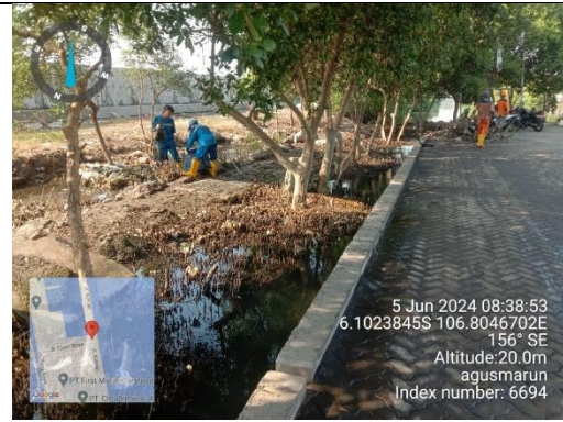
Pembersihan Sampah di Saluran Drainase Jalan Kakap
