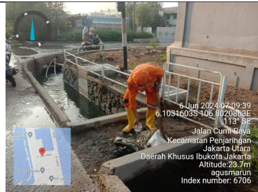
Pembersihan Sampah di Saluran Drainase Jalan Cumi Raya
