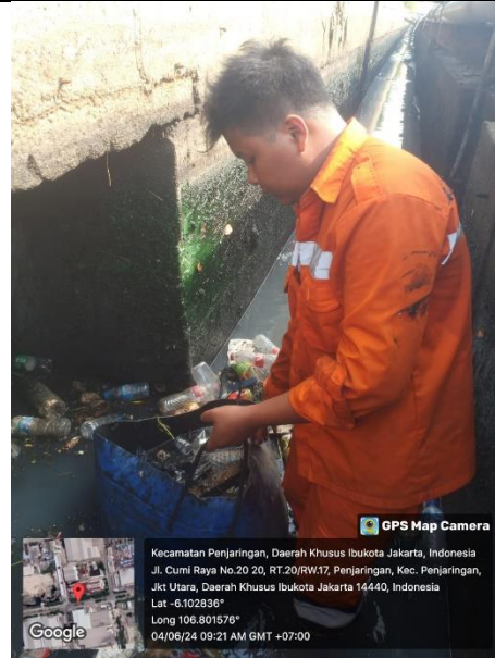
Pembersihan Sampah di Saluran Drainase Pompa Pengendali Banjir
