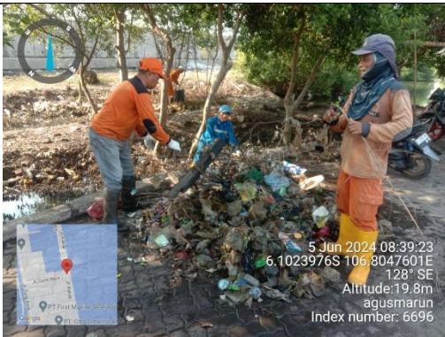
Pembersihan Sampah di Saluran Drainase Jalan Kakap
