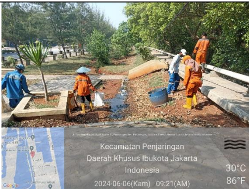
Pembersihan Sampah di Saluran Drainase Jalan Kakap
