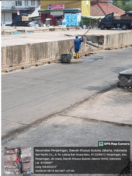
Pembersihan Sampah di Saluran Drainase Pasar Ikan Modern
