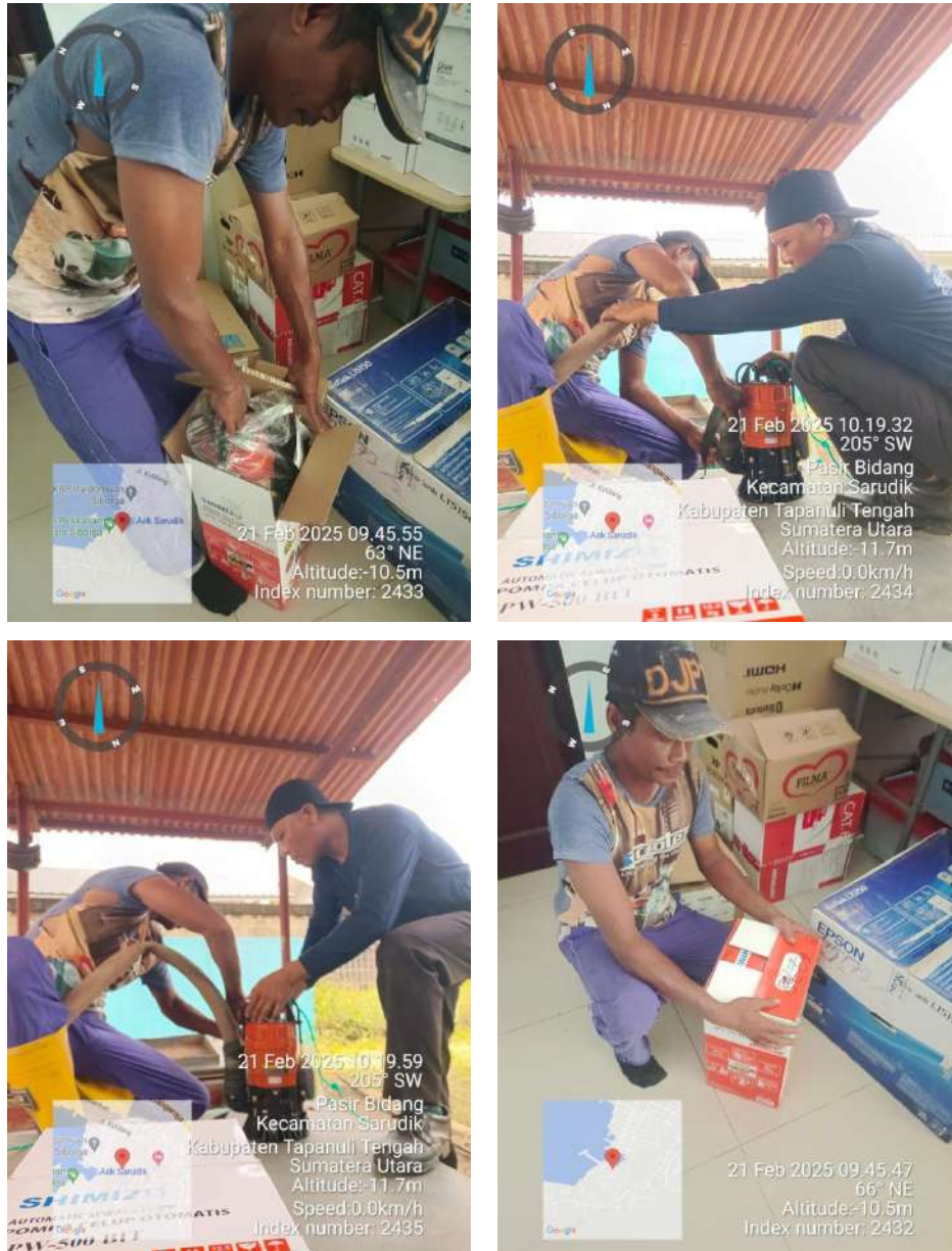
Gambar 2 Kegiatan Pemasangan Pompa Celup IPAL
